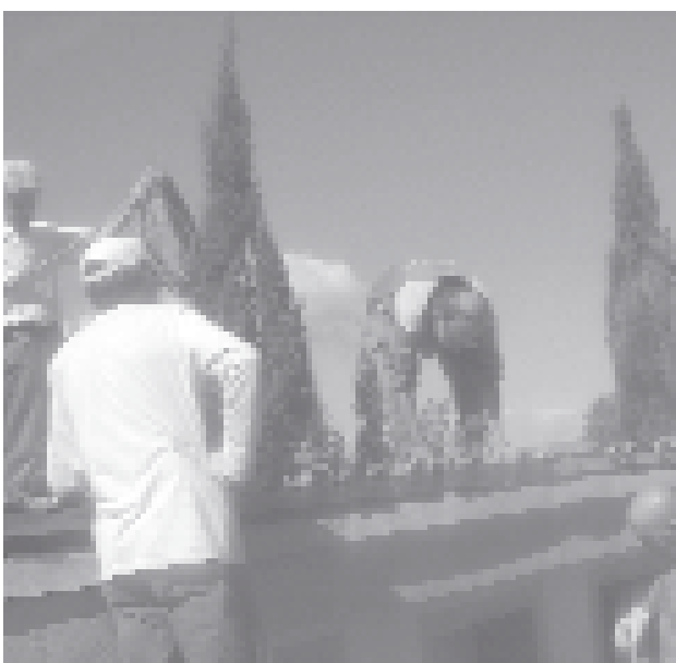
Aquí vemos parte del equipo de reparación.
